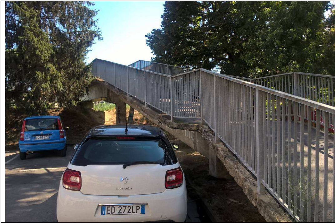
Fig.12 – Vista generale della rampa lato via Trento
