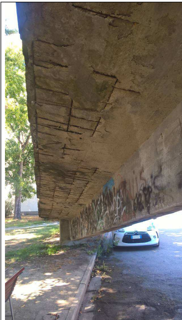
Fig.13 – Vista generale dell'intradosso di una delle due mensole che aggettano dalla rampa su via Trento
