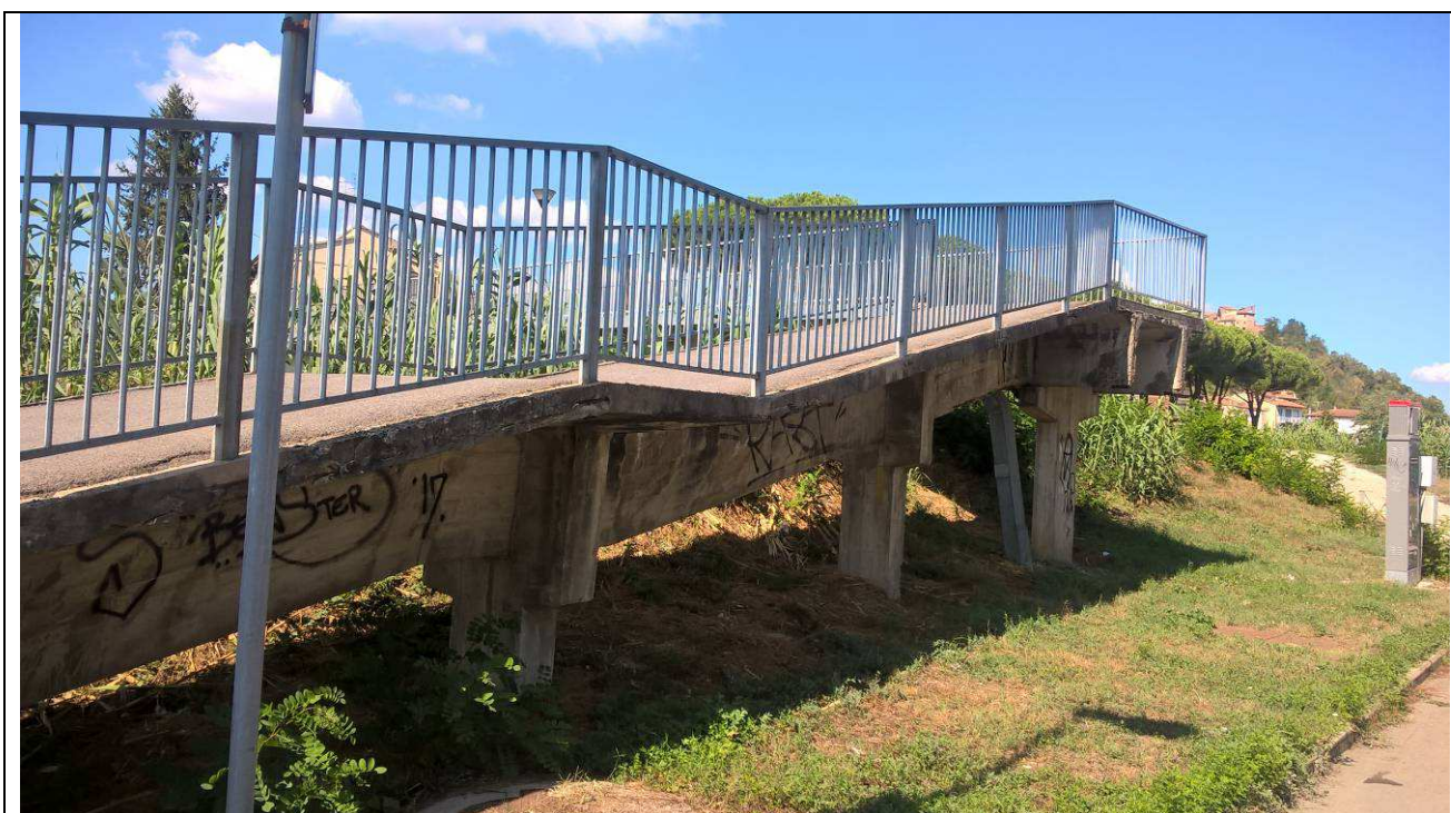
Fig.11 – Vista generale della rampa lato via Ciari
