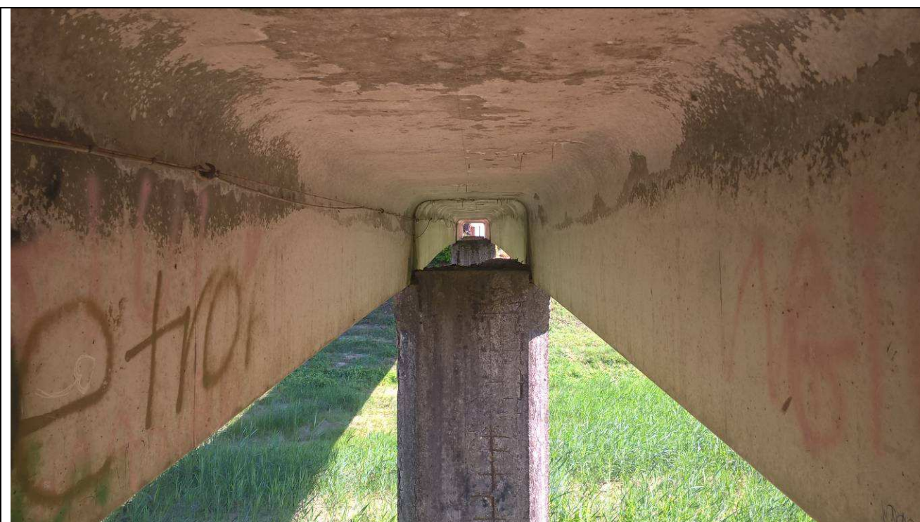
Fig. 5 – Vista della parte interna tra le nervature del tegolo precompresso, con dettaglio del baggio di contrasto in testa alla pila gettata in opera (pila in alveo lato via Trento)
