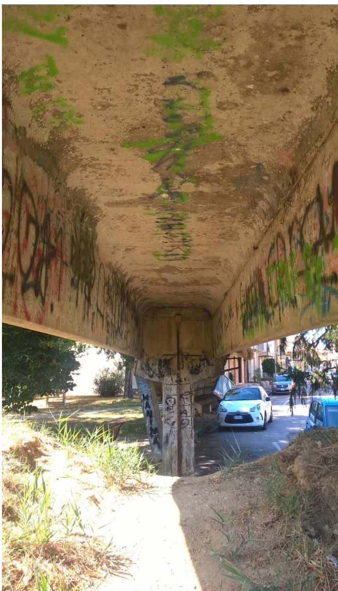
Figura 4 - Vista delle linee di distribuzione dell'impianto elettrico all'intradosso dell'impalcato e sulla spalla nord
