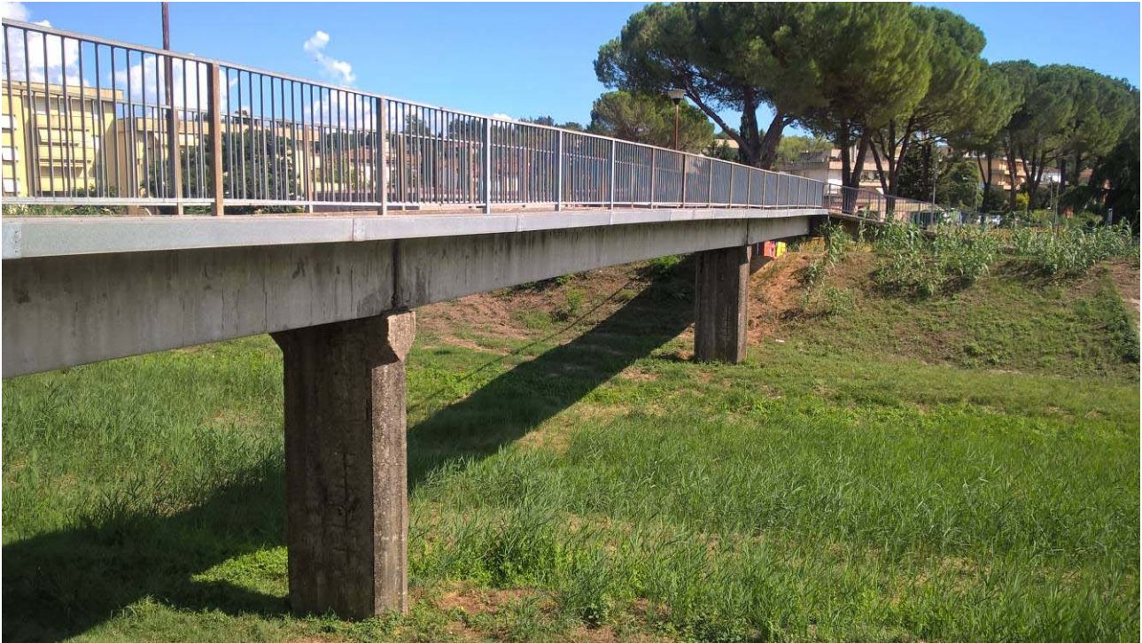
Figura 2 - Vista generale della passerella oggetto di intervento
