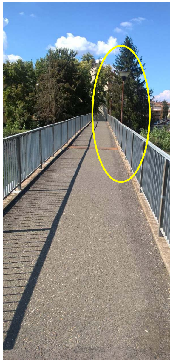
Figura 5 - Vista dei lampioni agganciati alla balaustra sul lato di monte della passerella
