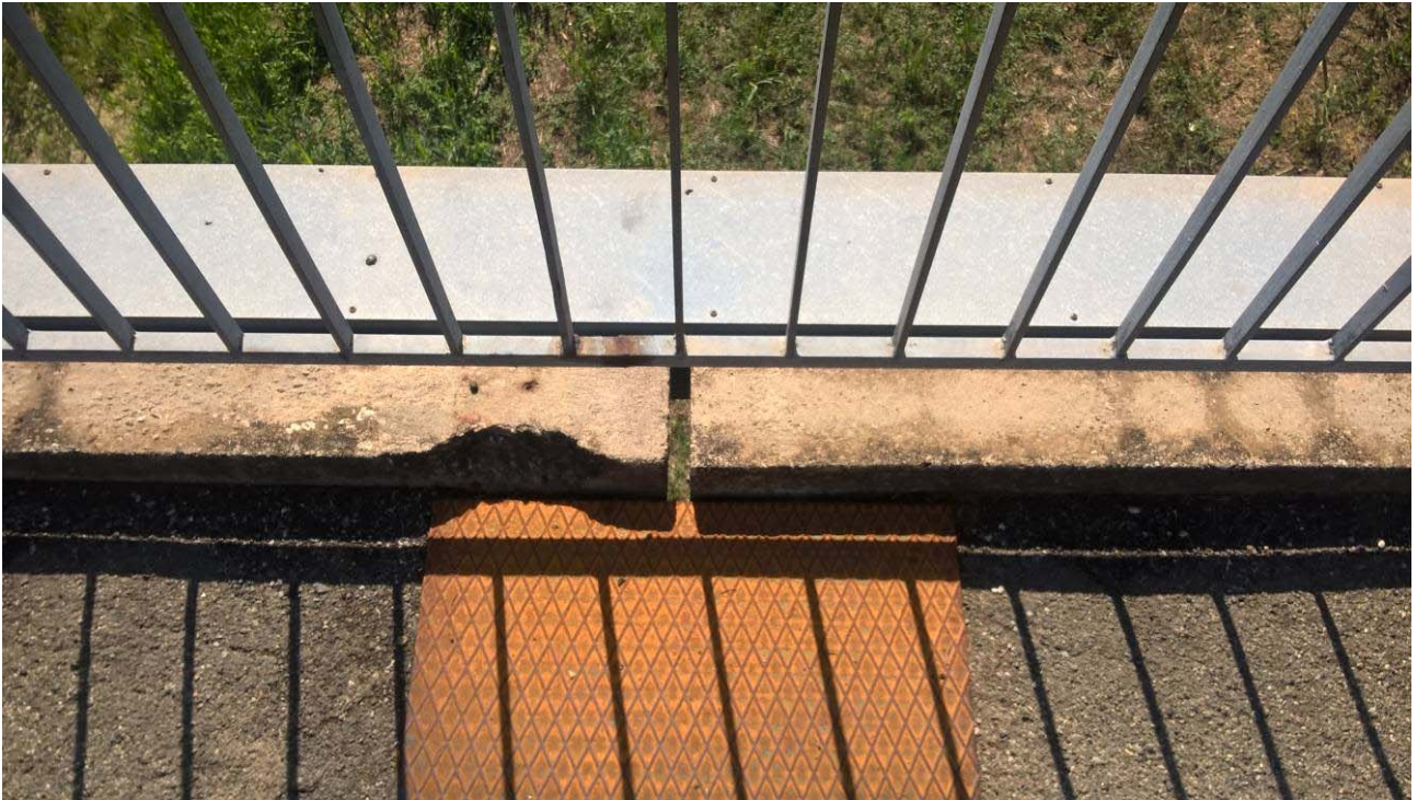
Figura 11 - Vista dall'alto della canaletta porta impianti posta in affiancamento all'impalcato (posizione corrispondente con uno dei due giunti sull'impalcato)
