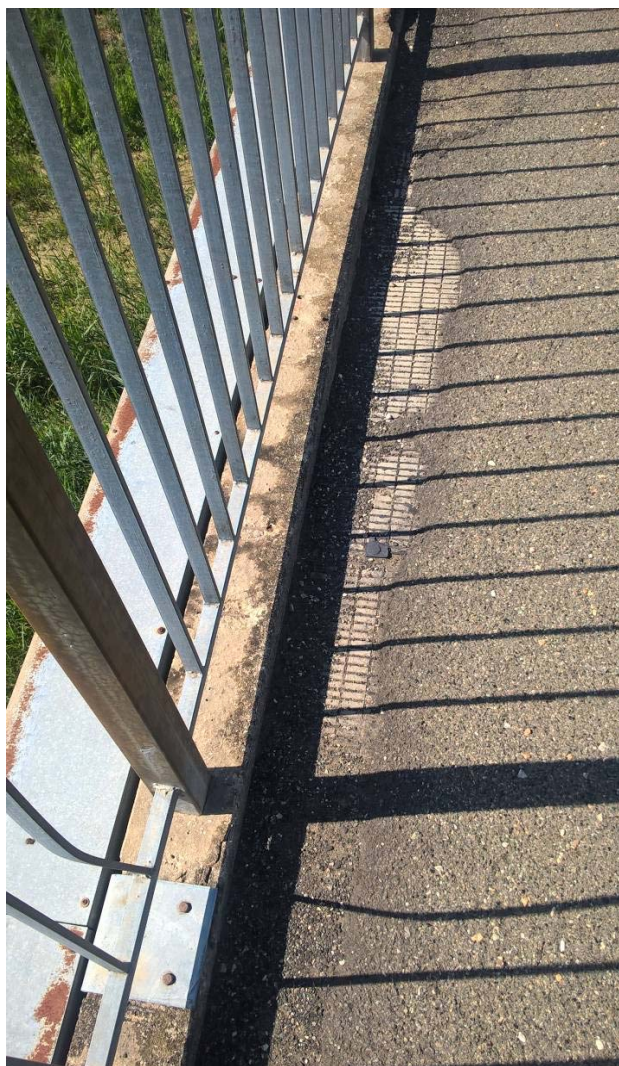
Figura 9 - Dettaglio della pavimentazione dell'impalcato e della canaletta porta impianti posta in affiancamento al lato di valle
