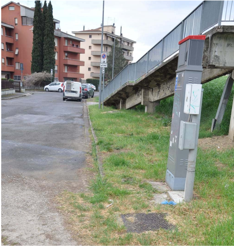
Figura 15 - Dettaglio di armadetto in prossimità della passerella sul lato di via Ciari
