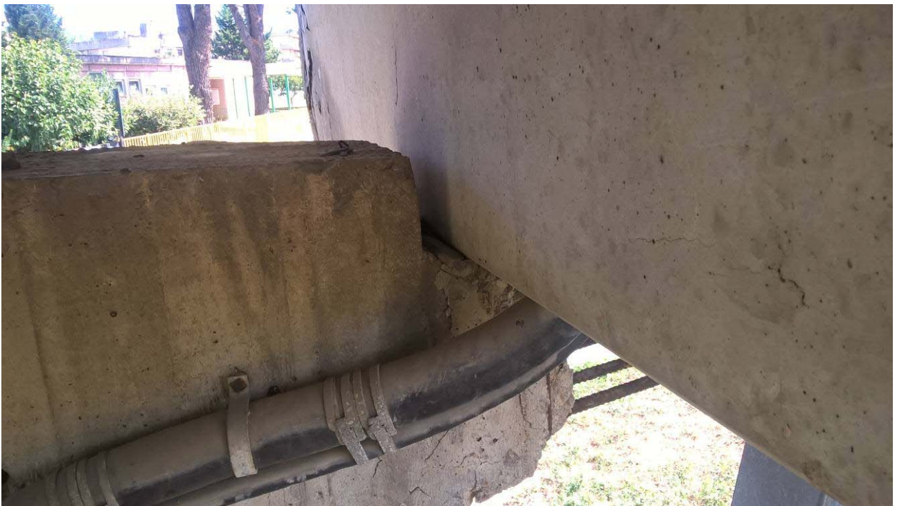
Figura 12 - Dettaglio dell'appoggio di una nervatura della trave in c.a.p. sulla spalla sud (si nota in dettaglio il fascio di cavi che sale verso la canaletta porta impianti posta lungo il fianco dell'impalcato)
