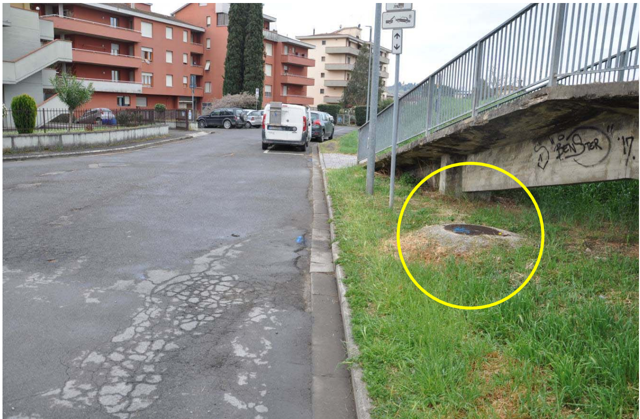
Figura 14 - Posizione del chiusino in ghisa che segnala il pozzetto della fognatura pubblica sul lato di via B. Ciari
