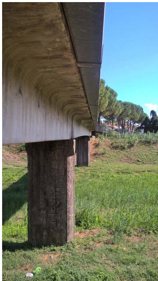
Figura 10 - Vista dell'intradosso della canaletta porta impianti sul fianco dell'impalcato
