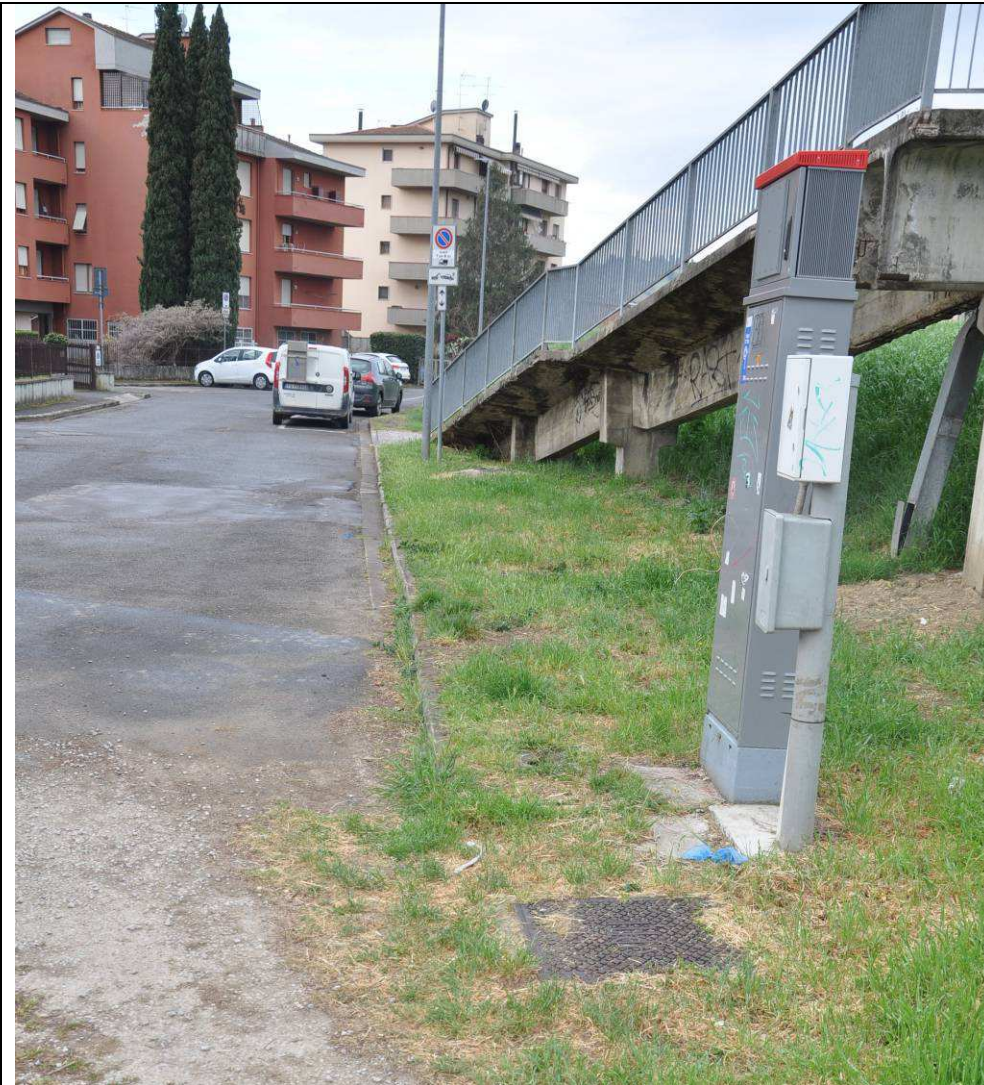
Fig. 39 – Dettaglio di armadietto in prossimità della passerella sul lato di via Ciari
