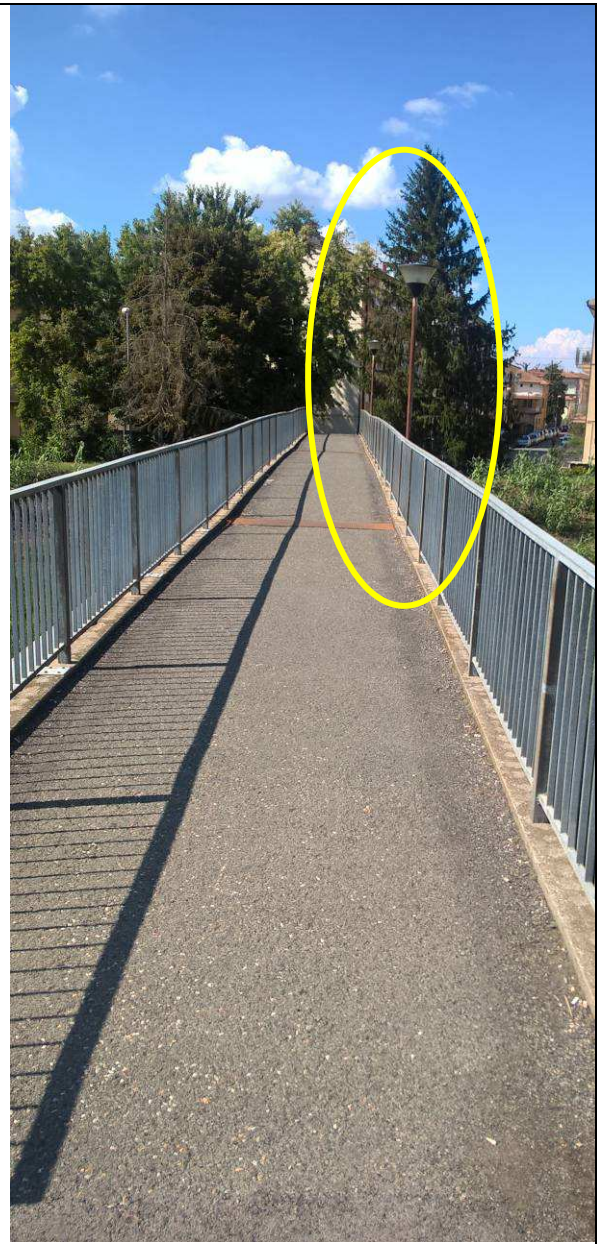
Fig. 29 – Vista dei lampioni agganciati alla balaustra sul lato di monte della passerella
