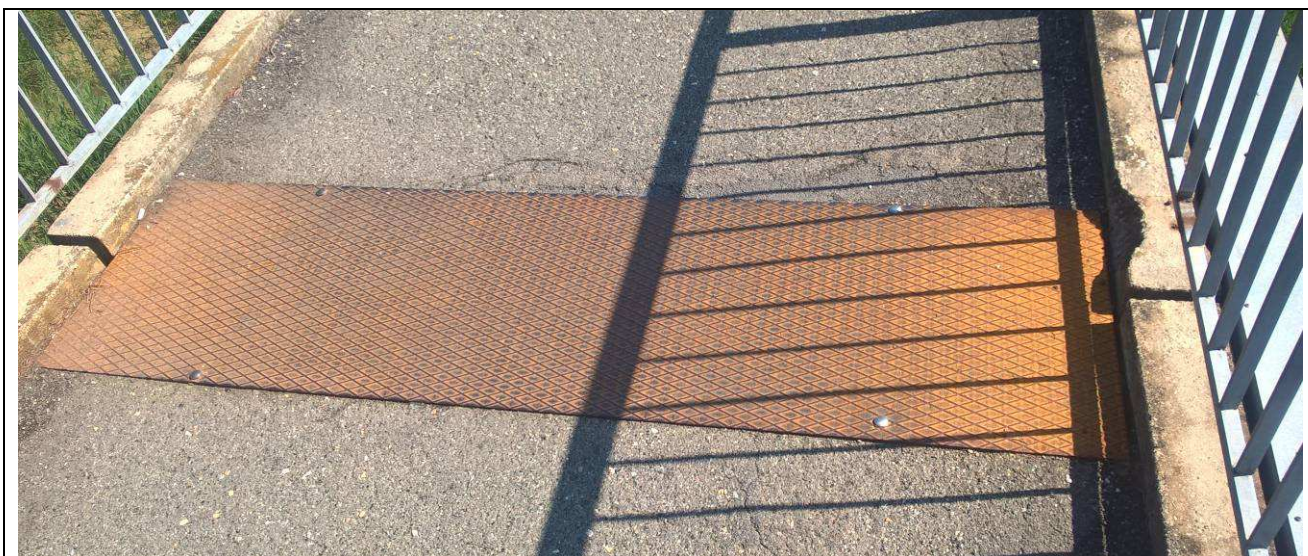
Fig. 20 – Lamiera a copertura del giunto tra due tratti di impalcato
