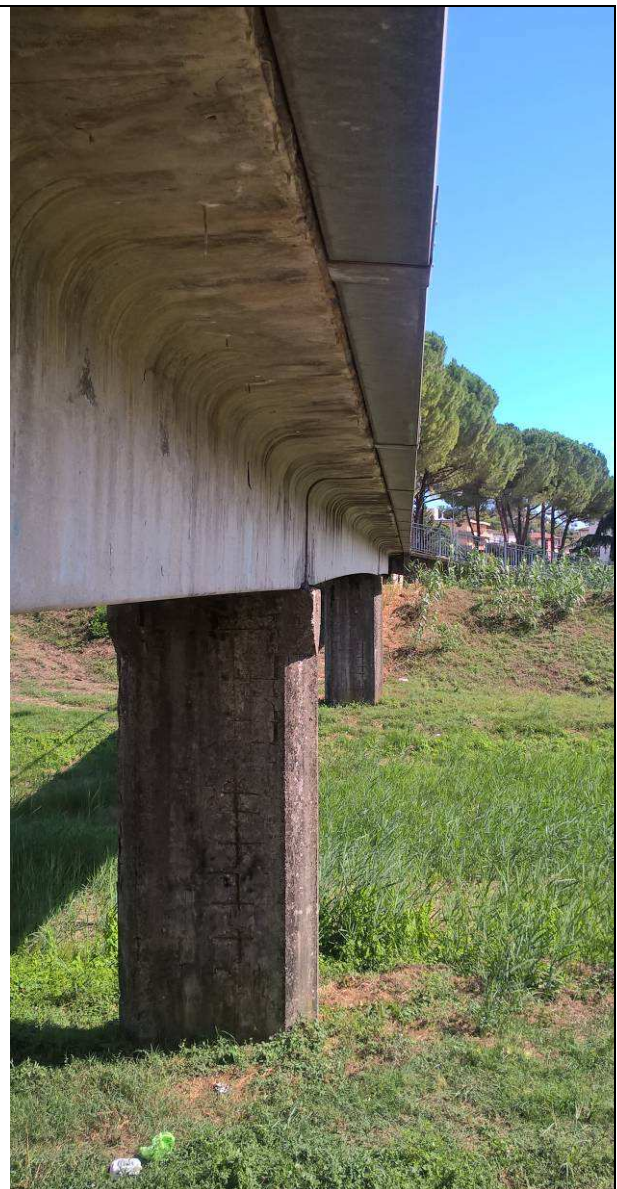
Fig. 34 – Vista dell'intradosso della canaletta porta impianti sul fianco dell'impalcato
