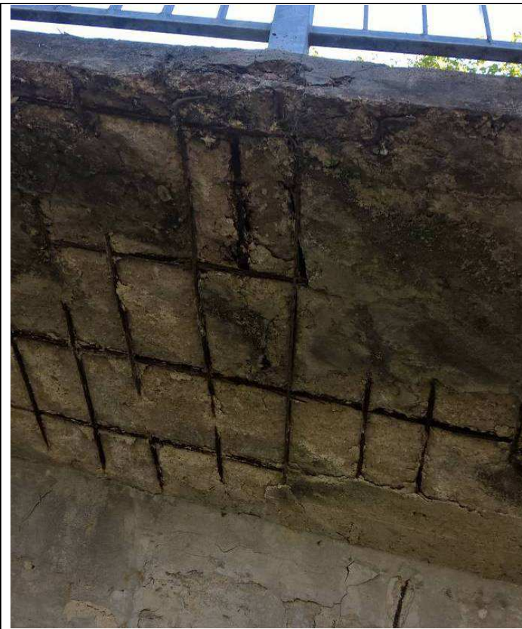
Fig. 53 – Dettaglio della mensola sulla rampa nord con ancoraggio di testa di un montante della balaustra
