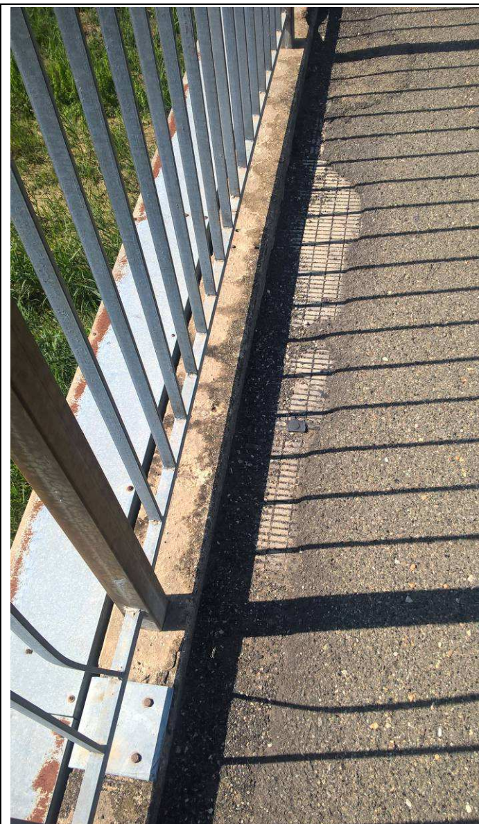
Fig. 33 – Dettaglio della pavimentazione dell'impalcato e della canaletta porta impianti posta in affiancamento al lato di valle
