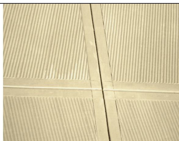
Fig. 69 – Dettaglio di calcestruzzo con trattamento superficiale a "spina di pesce" (ipotesi di finitura per la pavimentazione della passerella)
