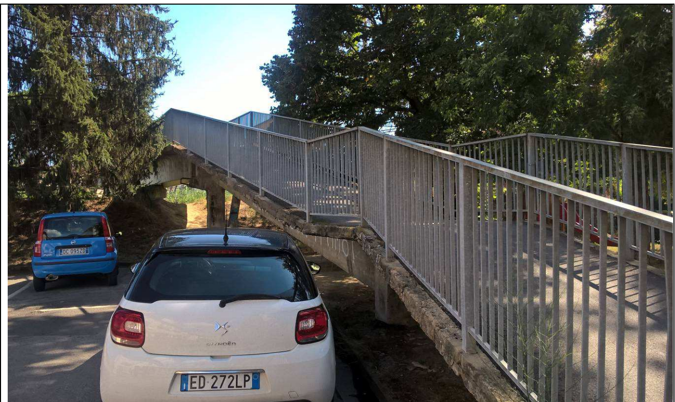
Fig. 14 – Vista generale della rampa lato via Trento
