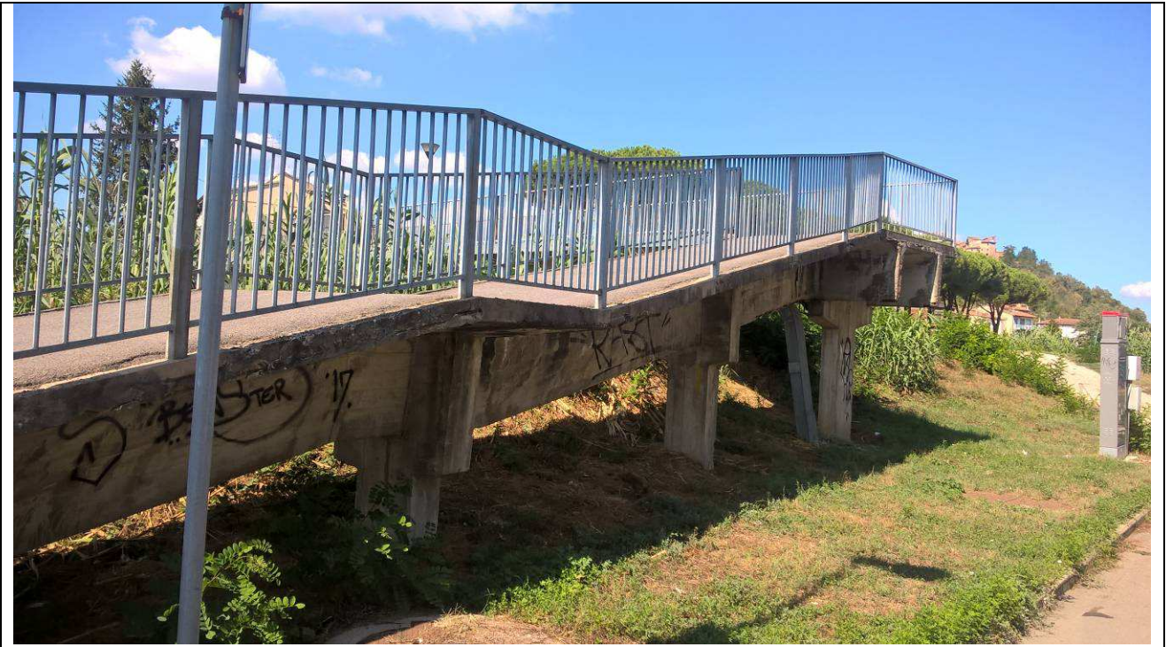
Fig. 13 – Vista generale della rampa lato via Ciari
