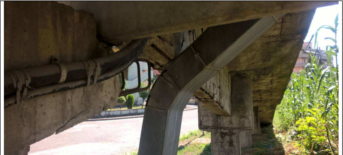
Fig. 32 – Dettaglio dell'estremità della canaletta porta impianti sul lato di via Ciari
