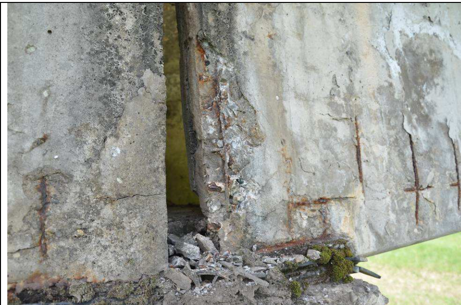
Fig. 47 – Dettaglio del degrado su una delle mensole della spalla nord (lato via Trento)
