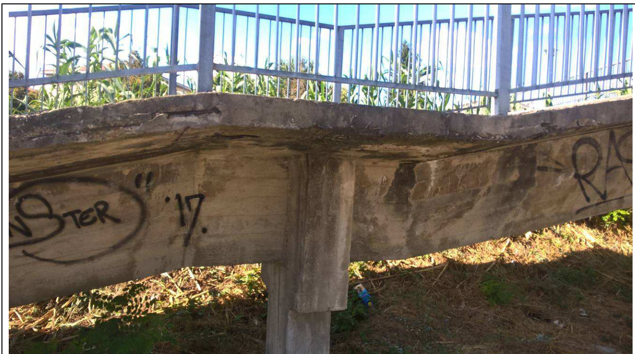
Fig. 8 – Vista laterale di un pilastro in c.a. a sostegno della rampa su via Ciari, con il caratteristico "pulvino" di raccordo sulla trave centrale
