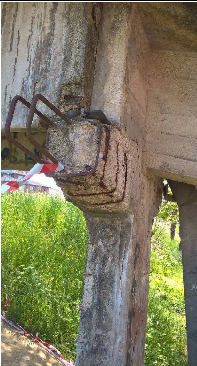
Fig. 47 – Dettaglio del degrado su una delle mensole della spalla nord (lato via Trento)
