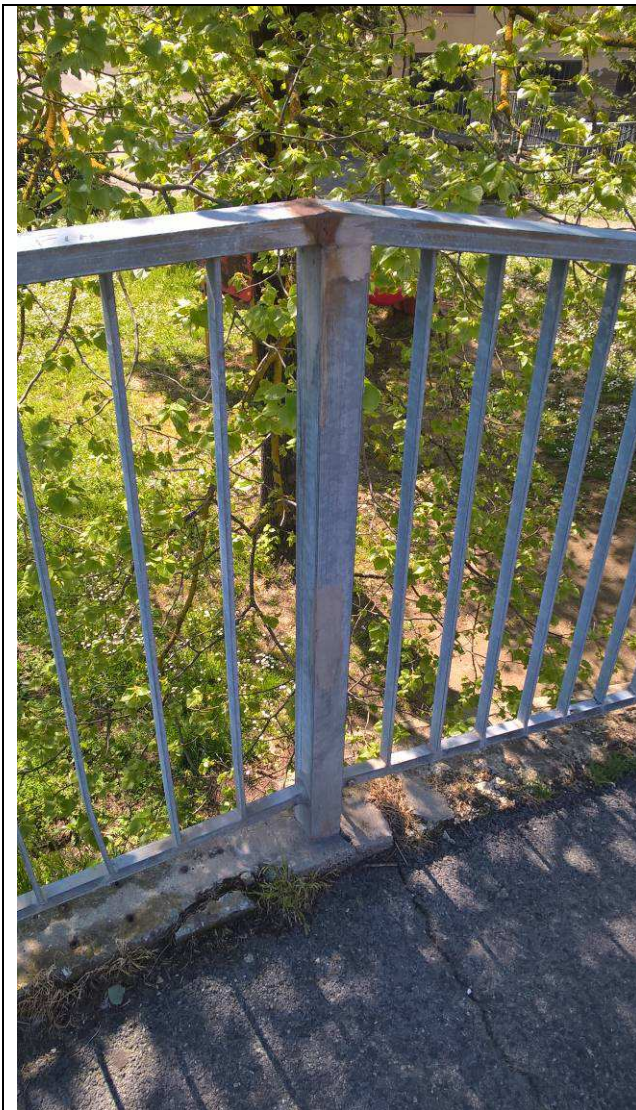
Fig. 26 – Dettaglio del montante ancorato all'estremità della trave di impalcato sul lato di via Trento (montante a comune con il campo di balaustra della rampa, lato valle)
