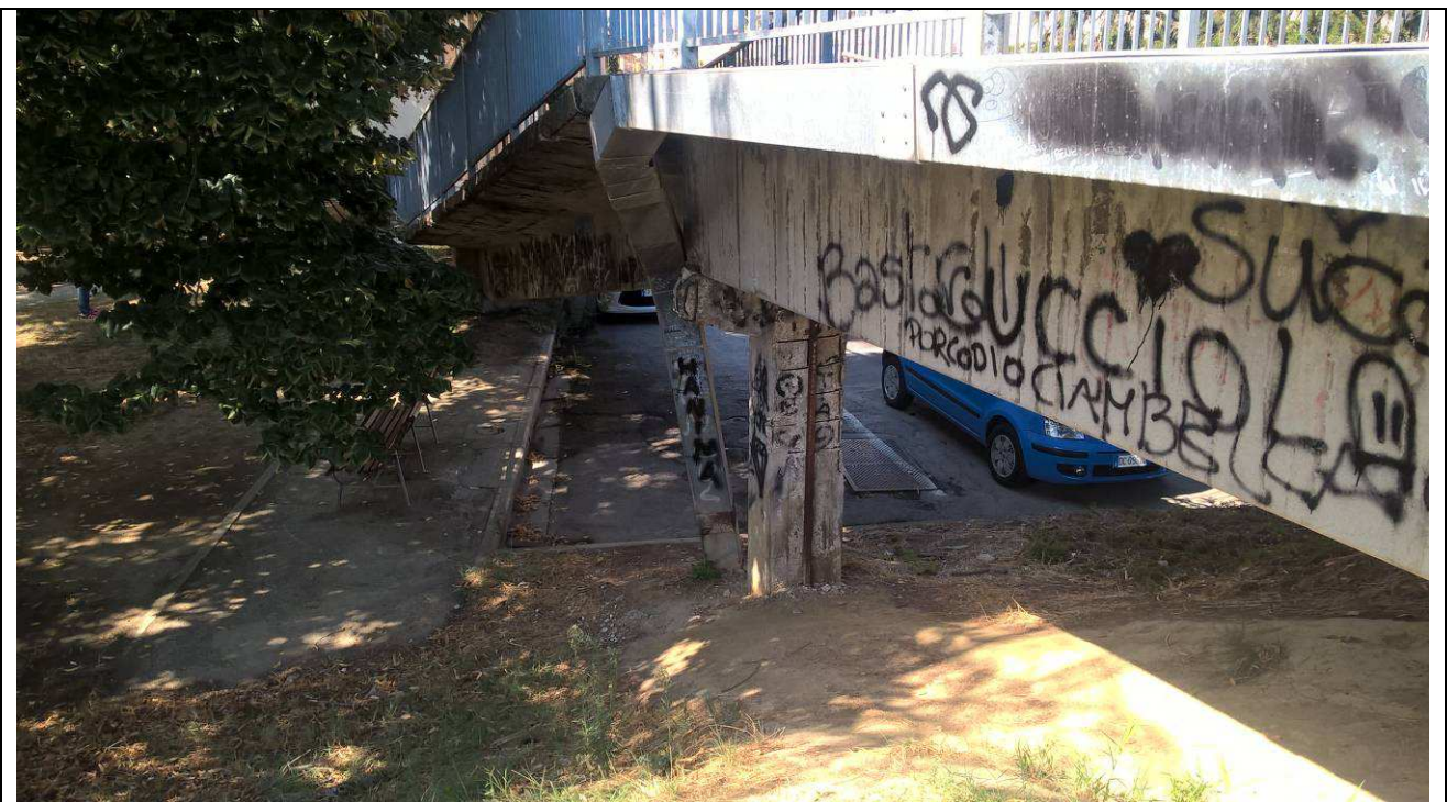
Fig. 31 – Dettaglio dell'estremità della canaletta porta impianti sul lato di via Trento
