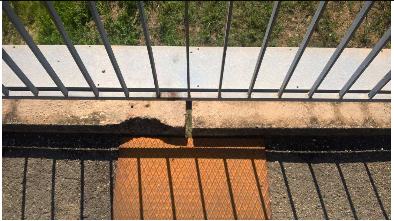
Fig. 35 – Vista dall'alto della canaletta porta impianti posta in affiancamento all'impalcato (posizione corrispondente con uno dei due giunti sull'impalcato)
