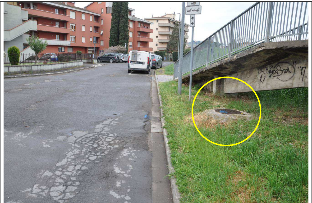
Fig. 38 – Posizione del chiusino in ghisa che segnala il pozzetto della fognatura pubblica sul lato di via B. Ciari
