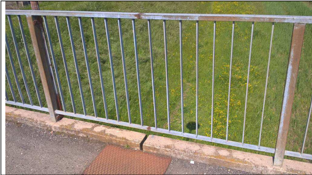
Fig. 25 – Particolare di un campo di parapetto all'altezza di un giunto sull'impalcato (i correnti tubolari della balaustra sono collegati senza soluzione di continuità)
